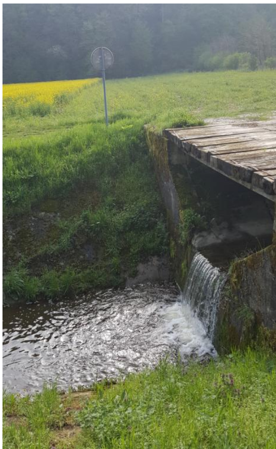
Slika 5.1. Vodotok Svetojanski jarak nizvodno od naselja Svata Ana
